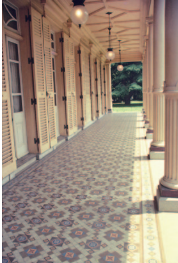
旧岩崎邸 洋館ベランダのタイル
