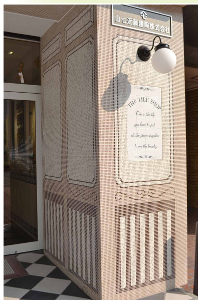
入口左側タイル柱型
