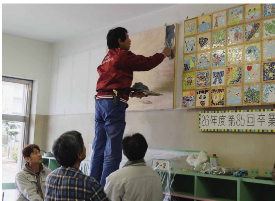
コンパネ下地板に接着剤張り
