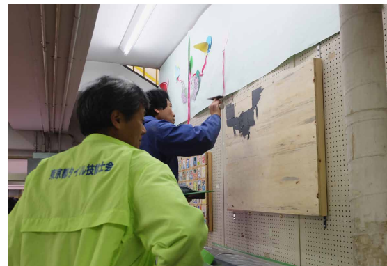
コンパネ下地板に接着剤を塗る
