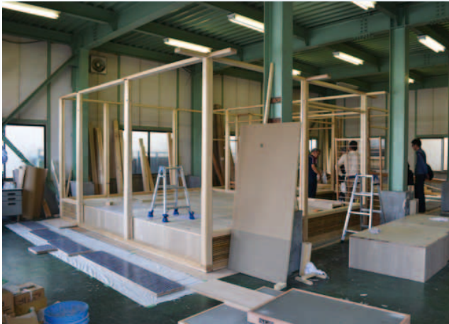
作業場での仮組み作業
