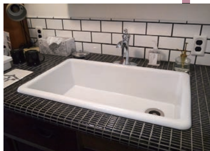
洗面台手前の曲面部分のタイル張りに職人技が光る。
